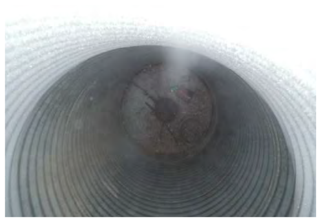
MH7D insulation plug.
